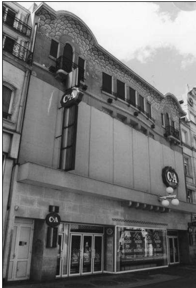
L'ancien Palace , seule une partie de la façade subsiste.
